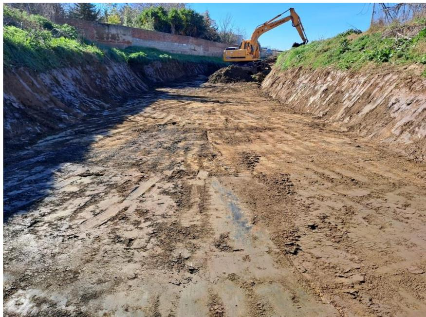
El colector es el conducto de alcantarillado público al que van a parar las aguas residuales y pluviales de los diversos ramales, por lo que es necesario llevar a cabo en estos, tareas de saneamiento a modo de mantenimiento.
