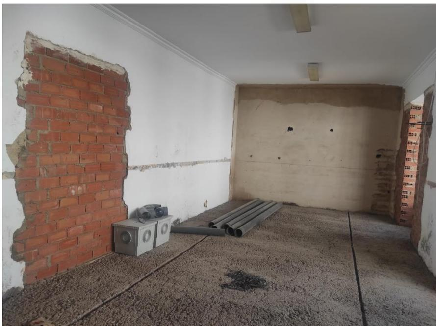
Los primeros trabajos han consistido en la limpieza integral del edificio de enseres y documentación, caída de tabiques, cierre de algunas puertas y ventanas y acometida de nueva red de canalización de aguas limpias y residuales.
