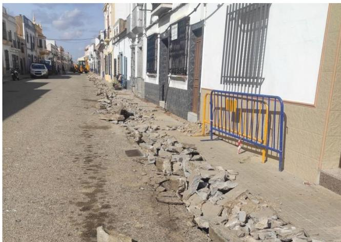
Los acerados de dicha vía pública se encontraban en muy mal estado, por ello ya han comenzado los trabajos de sustitución de sus bordillos, soleras y solerías.
